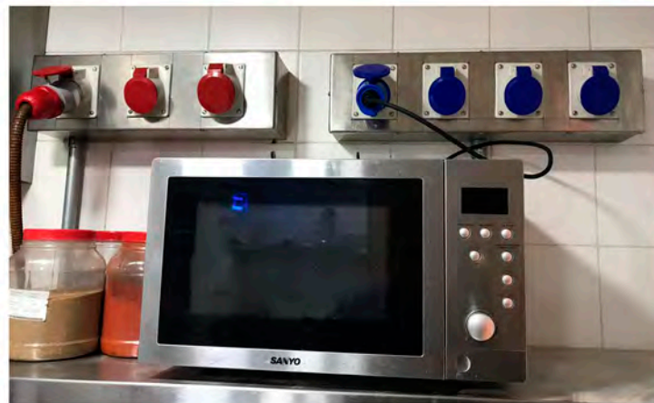
Armado de tomas en Cocina
