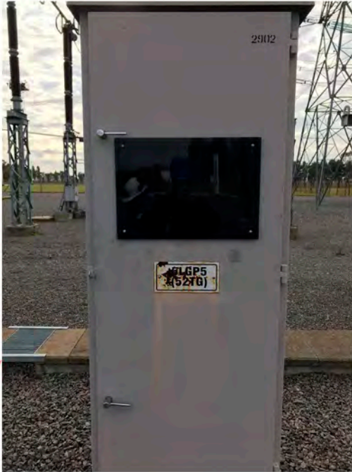
Armado de gabinete
